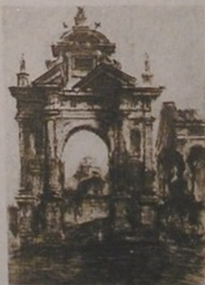
Acquaforte di G. Vegetti
