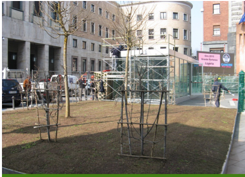
L'aiuola in allestimento in Piazza Monte Grappa
