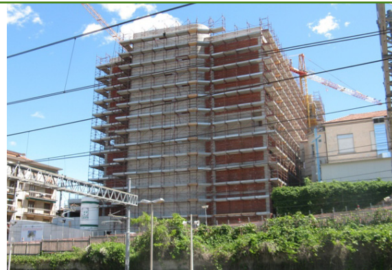
Il nuovo Del Ponte in costruzione
