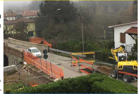
I lavori al ponte di via Giordani
