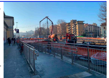
Lavori nell'area stazione FFSS
